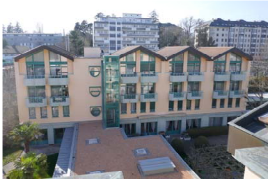
Le bâtiment annexe vu depuis le toit du bâtiment principal
