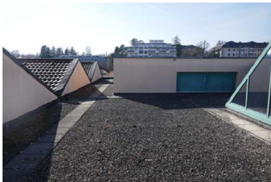
La toiture plate du bâtiment principal
